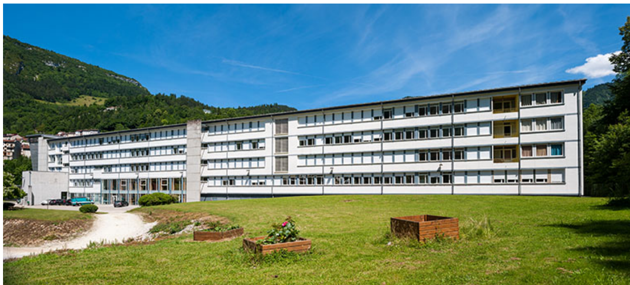
Internat : façade postérieure, vue générale.
