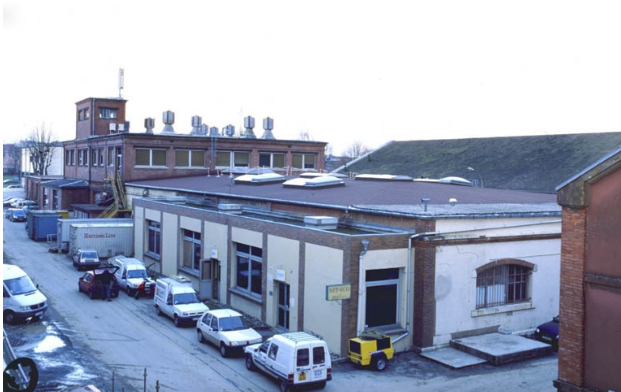
Atelier de blanchiment : vue de trois quarts arrière.
