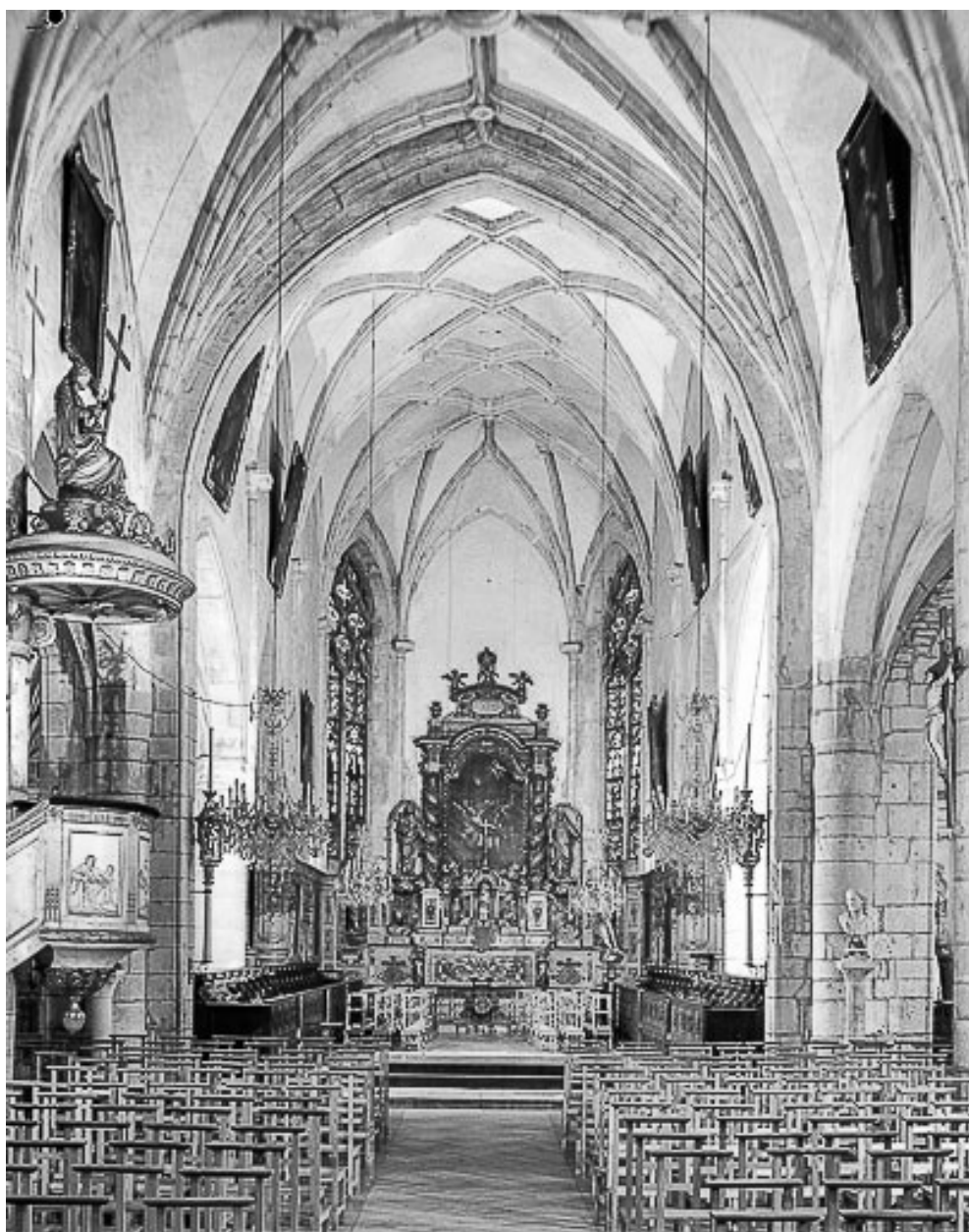
Intérieur : le chœur vu depuis la nef.
