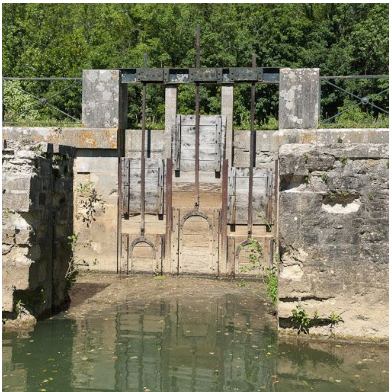
Détail des vannes en bois.
