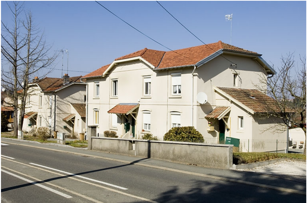
Habitations à quatre logements des années 1930.
