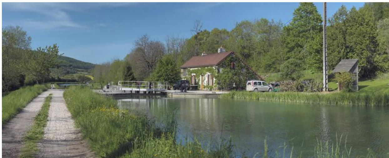
Vue d'ensemble de l'amont du site d'écluse.
