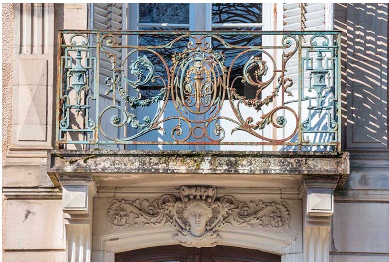
Façade est, détail : balcon.
