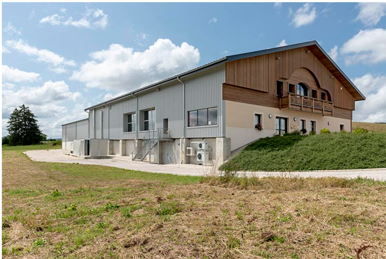
Façades antérieure et latérale gauche.
