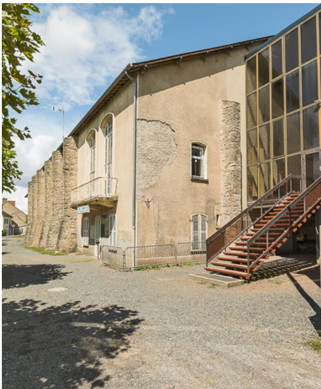
Vue du bâtiment et des contreforts.
