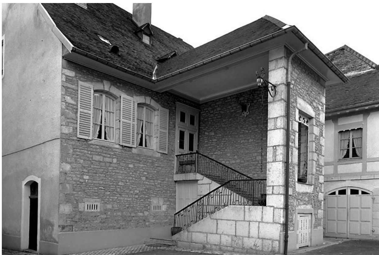
Façade postérieure, vue de trois quarts droit.
