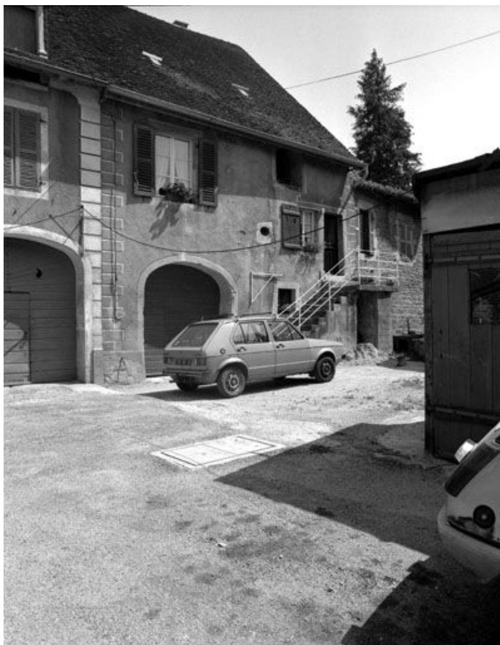
Ferme de vigneron située rue Traversière.
