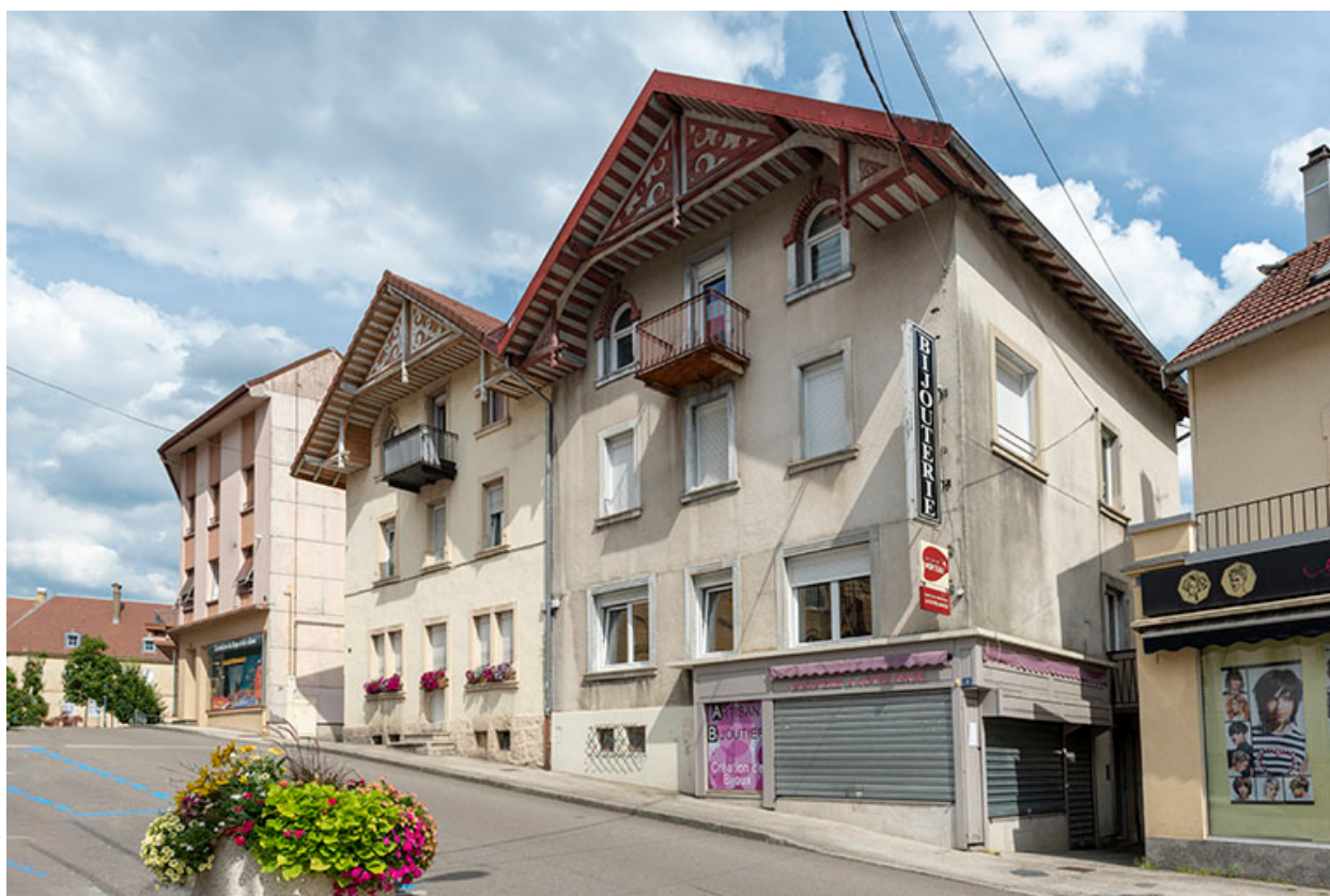
Maisons jumelles et ateliers d'horlogerie de Georges Michel et des frères Bruchon, 1-3 rue Pasteur.
