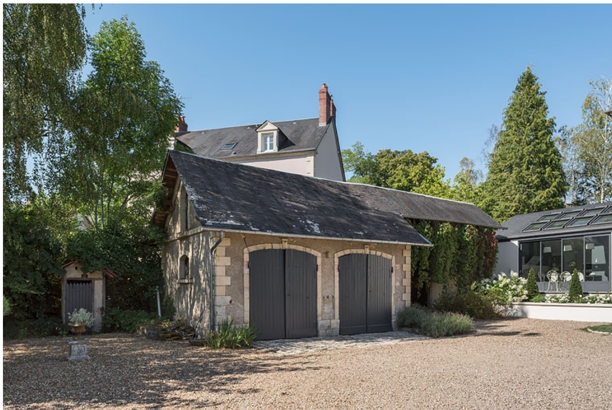
Dépendance (remise-écurie) côté sud.
