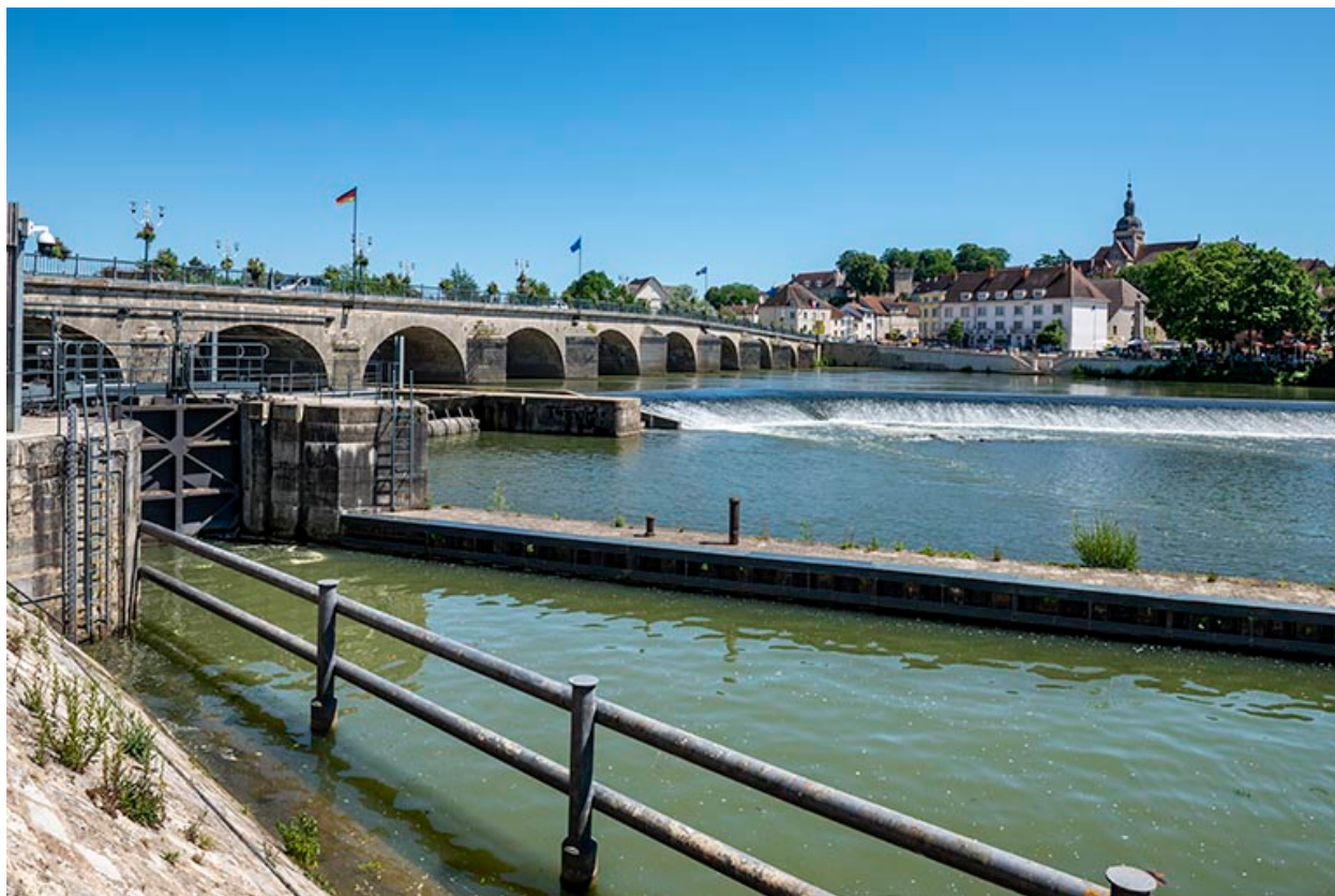
Vue générale du début du bief d'Apremont.
