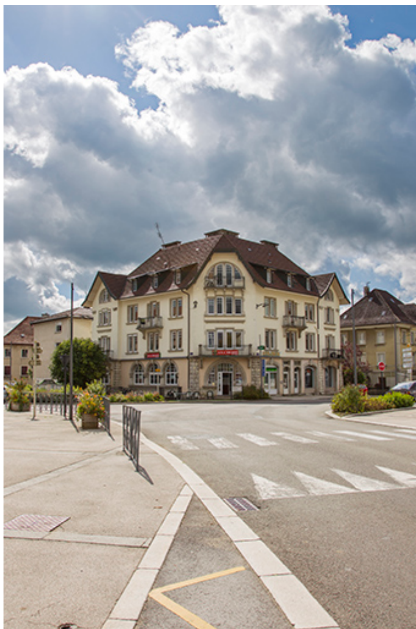
Vue d'ensemble, depuis le nord-ouest (cadrage vertical).
