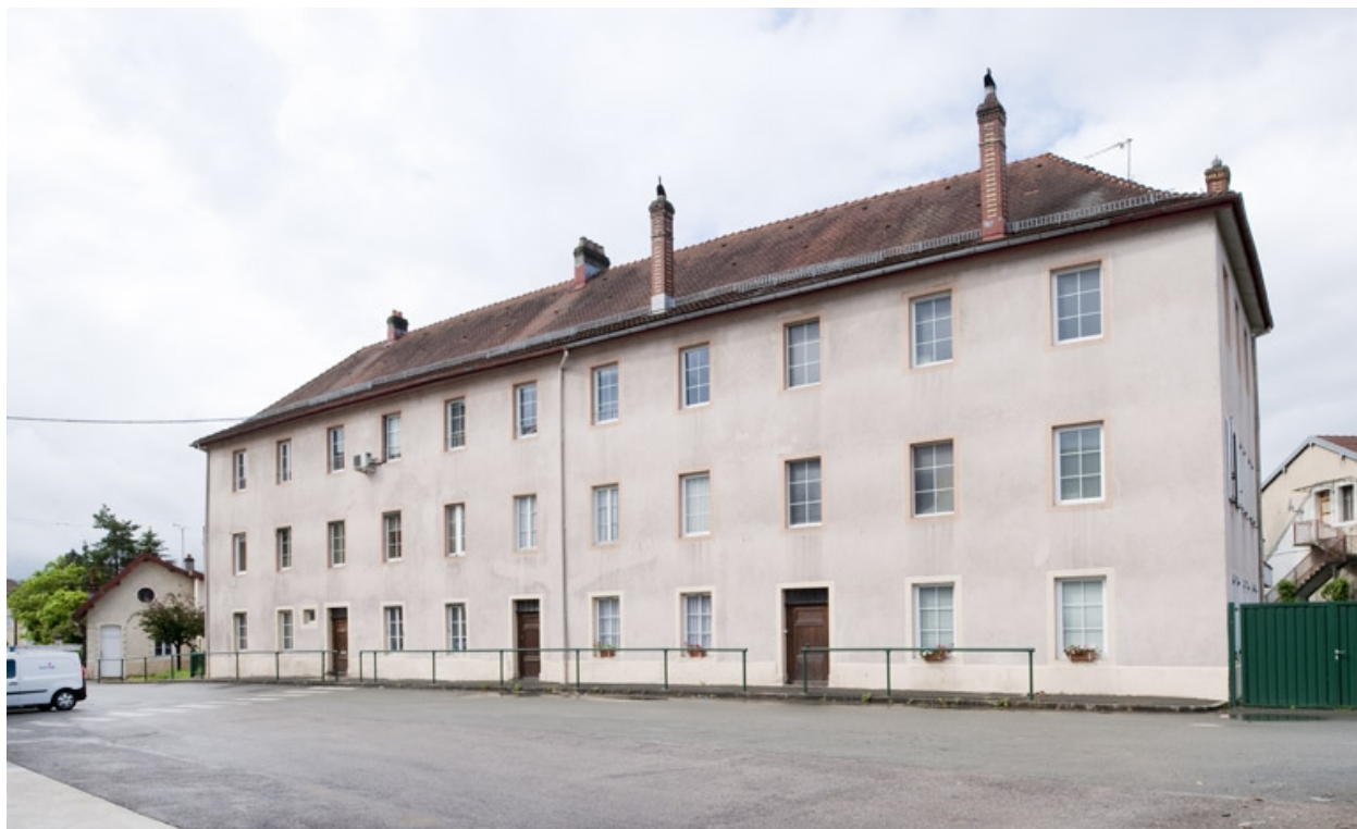
Bâtiment administratif et logement patronal. Façade antérieure.
