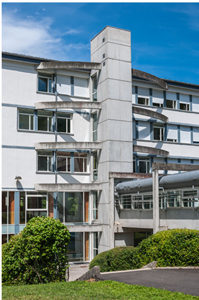
Internat : détail de la façade antérieure.
