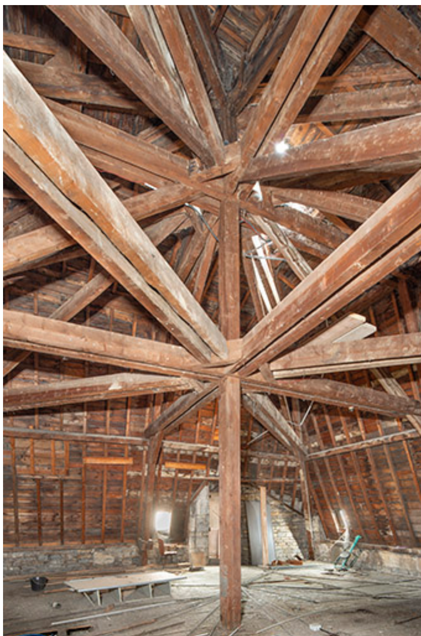
Charpente du pavillon ouest.
