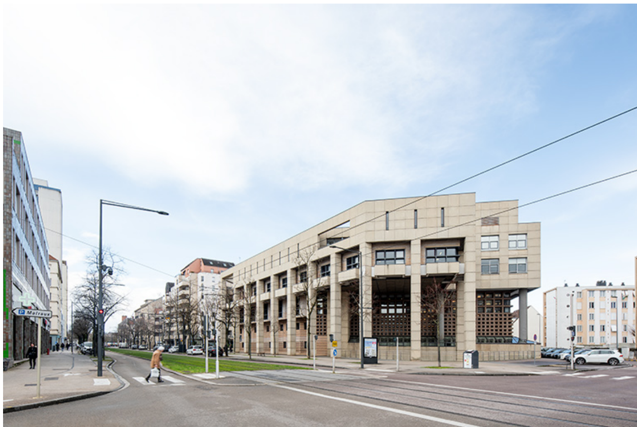
Situation sur le boulevard Georges-Clemenceau, vue depuis le nord-est.
