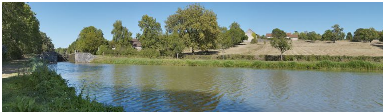
Vue générale du site d'écluse, d'aval.
