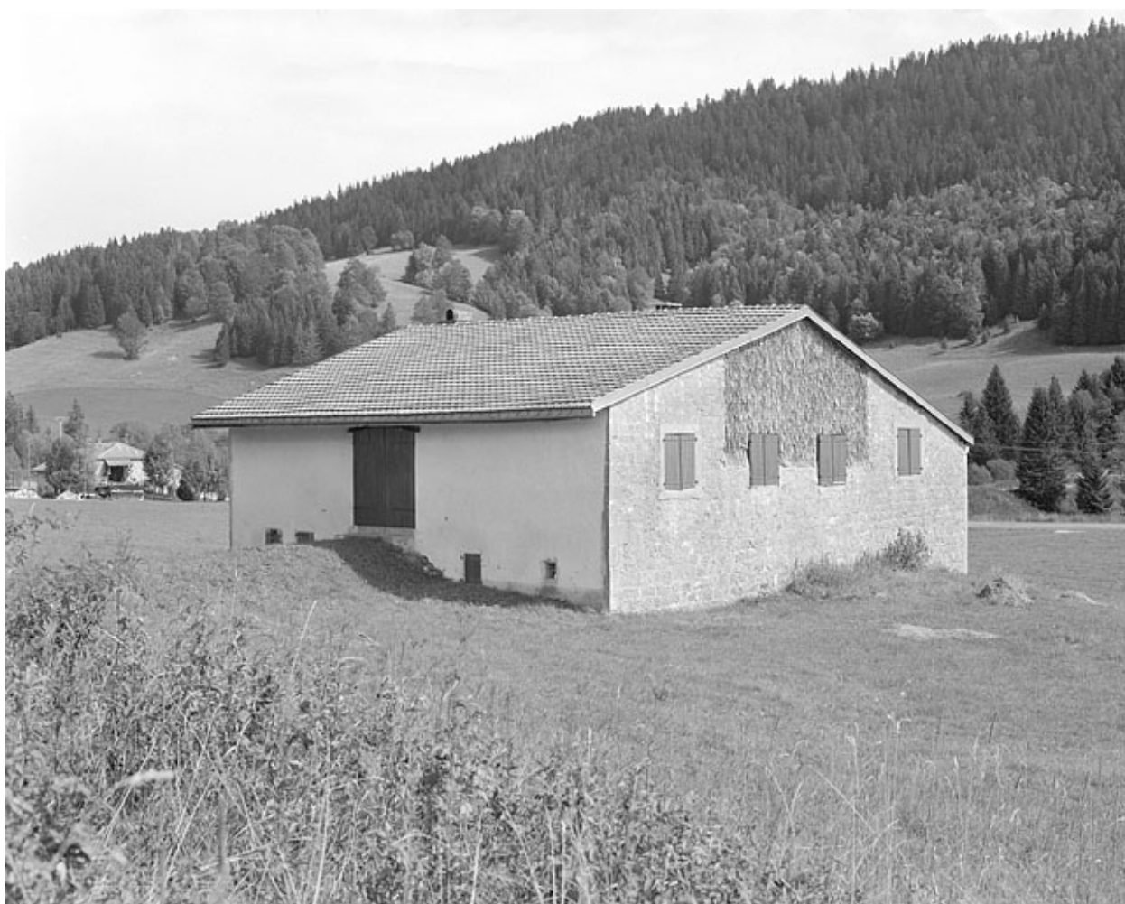
Façade postérieure et face sud-ouest.
