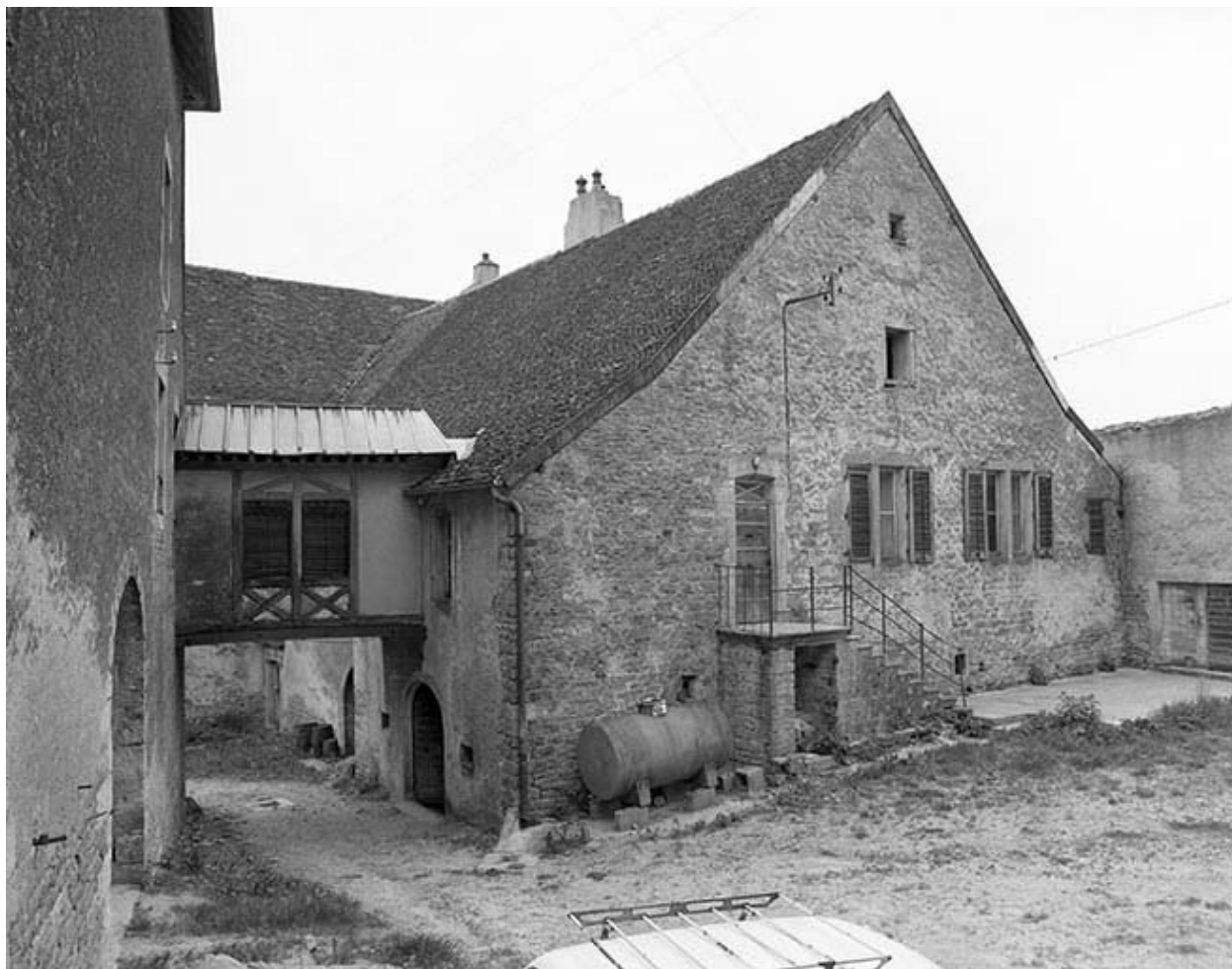
Façade est, partie droite.
