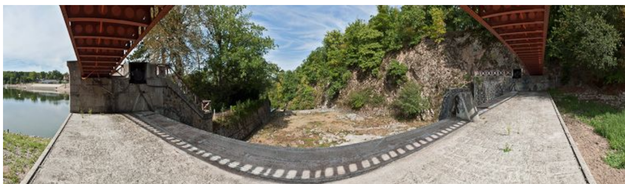
Vue du déversoir.
