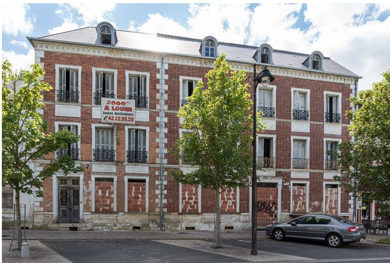
Façade de l'extension de Jules Guimard.
