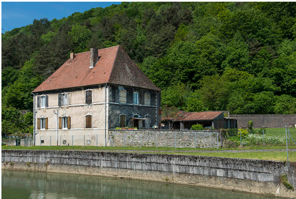
Bief d'amenée et logement patronal.
