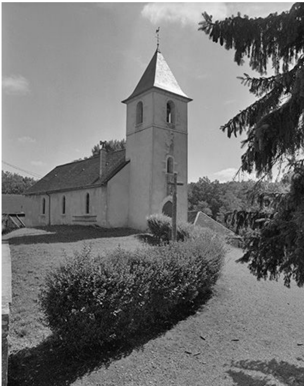
Façades antérieure et latérale gauche.
