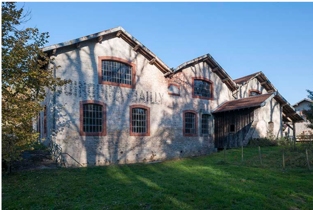
Ateliers ouest vus de trois quarts droite.
