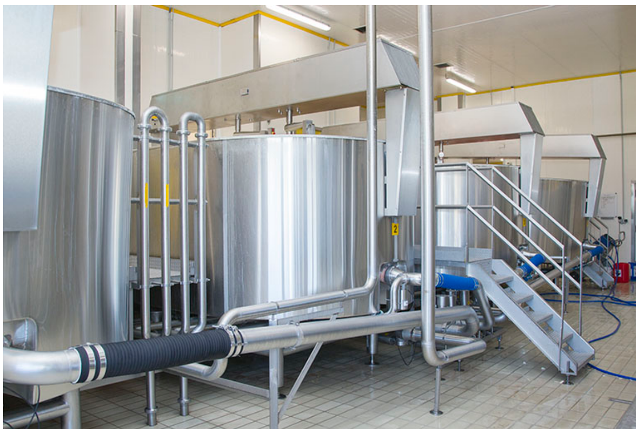
Atelier de fabrication : les quatre cuves.
