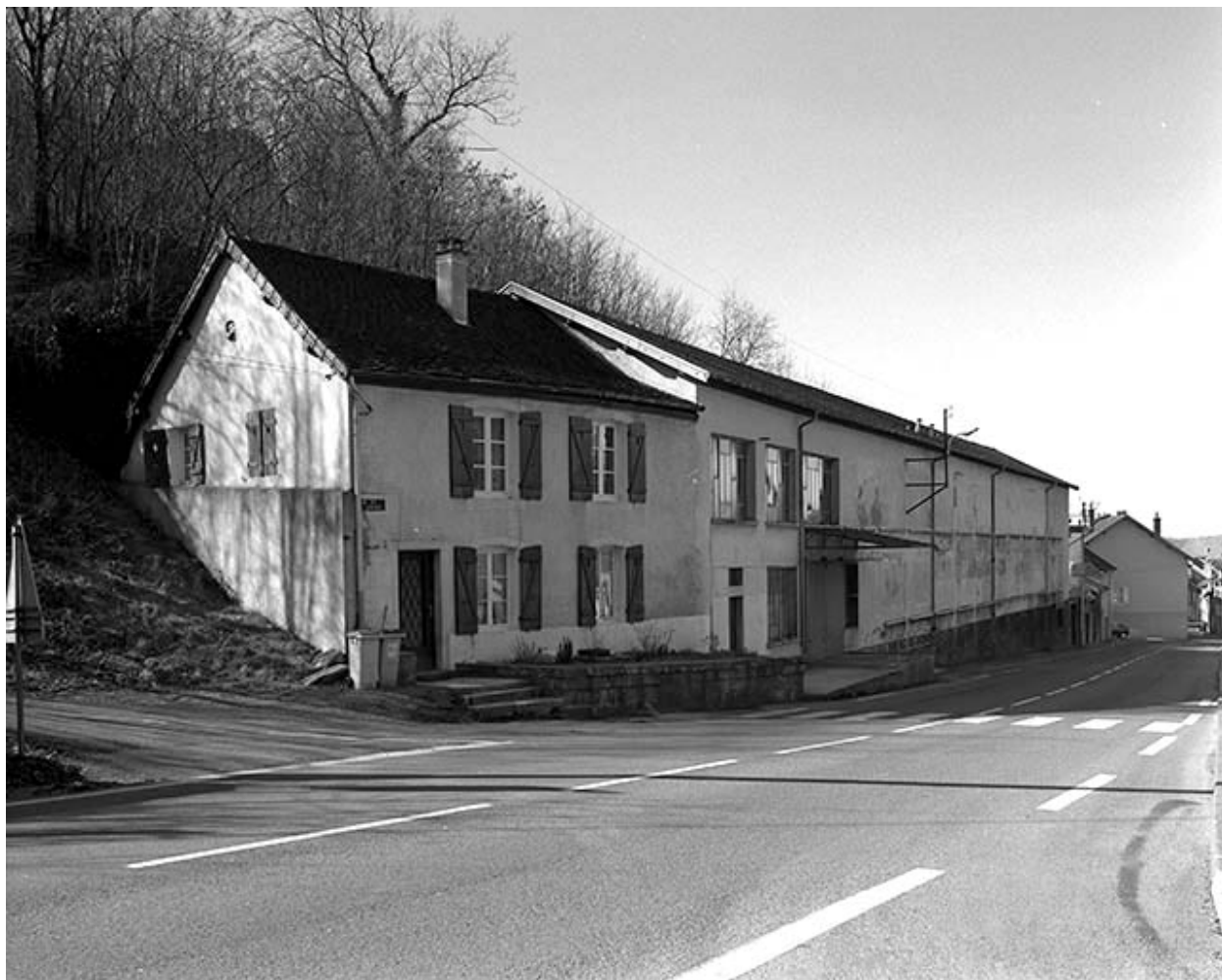
Logement, bureau et atelier de fabrication.
