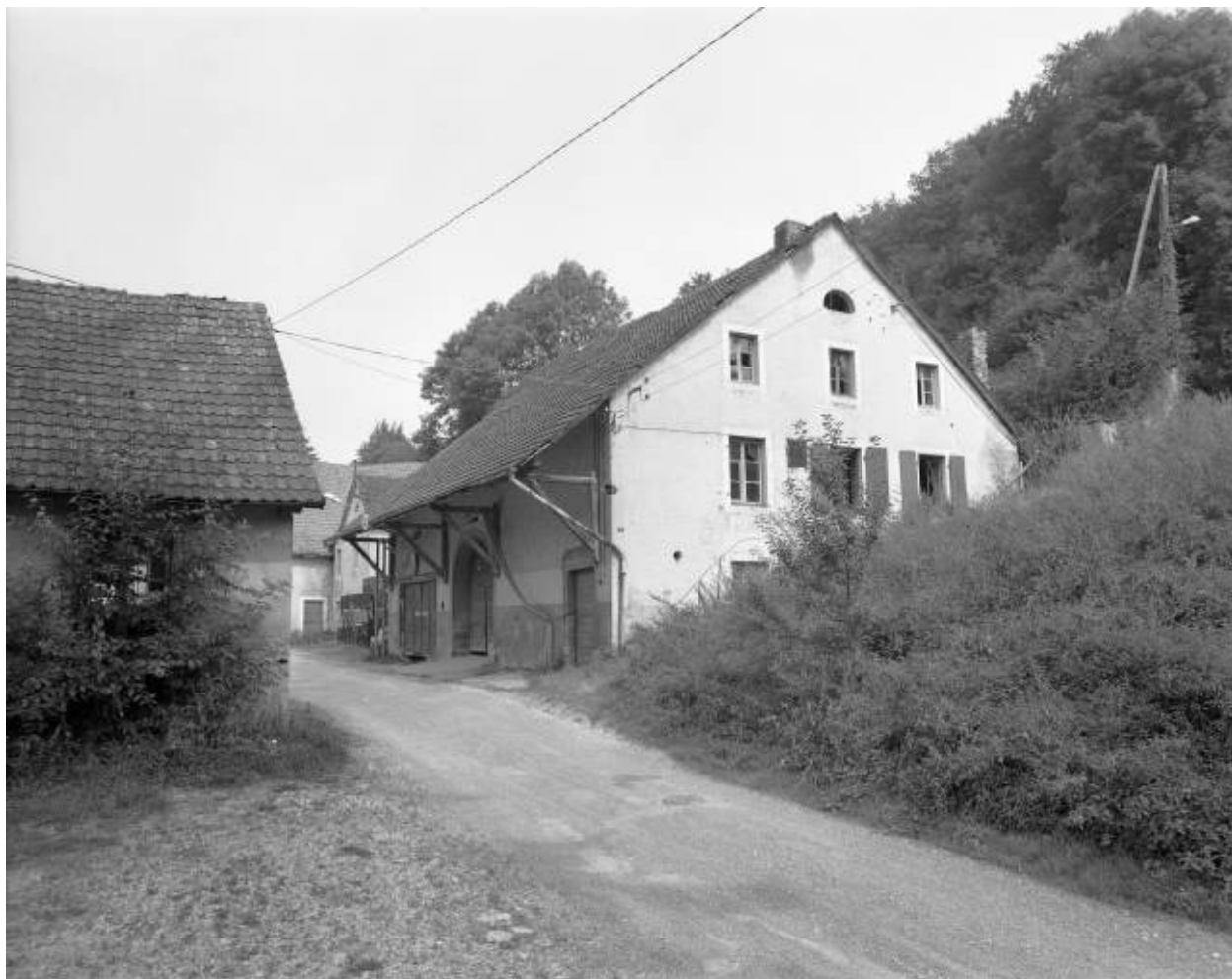
Bâtiment agricole en 1981.
