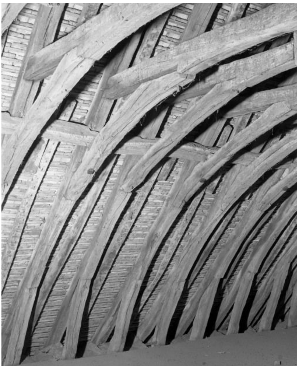
Charpente du comble
