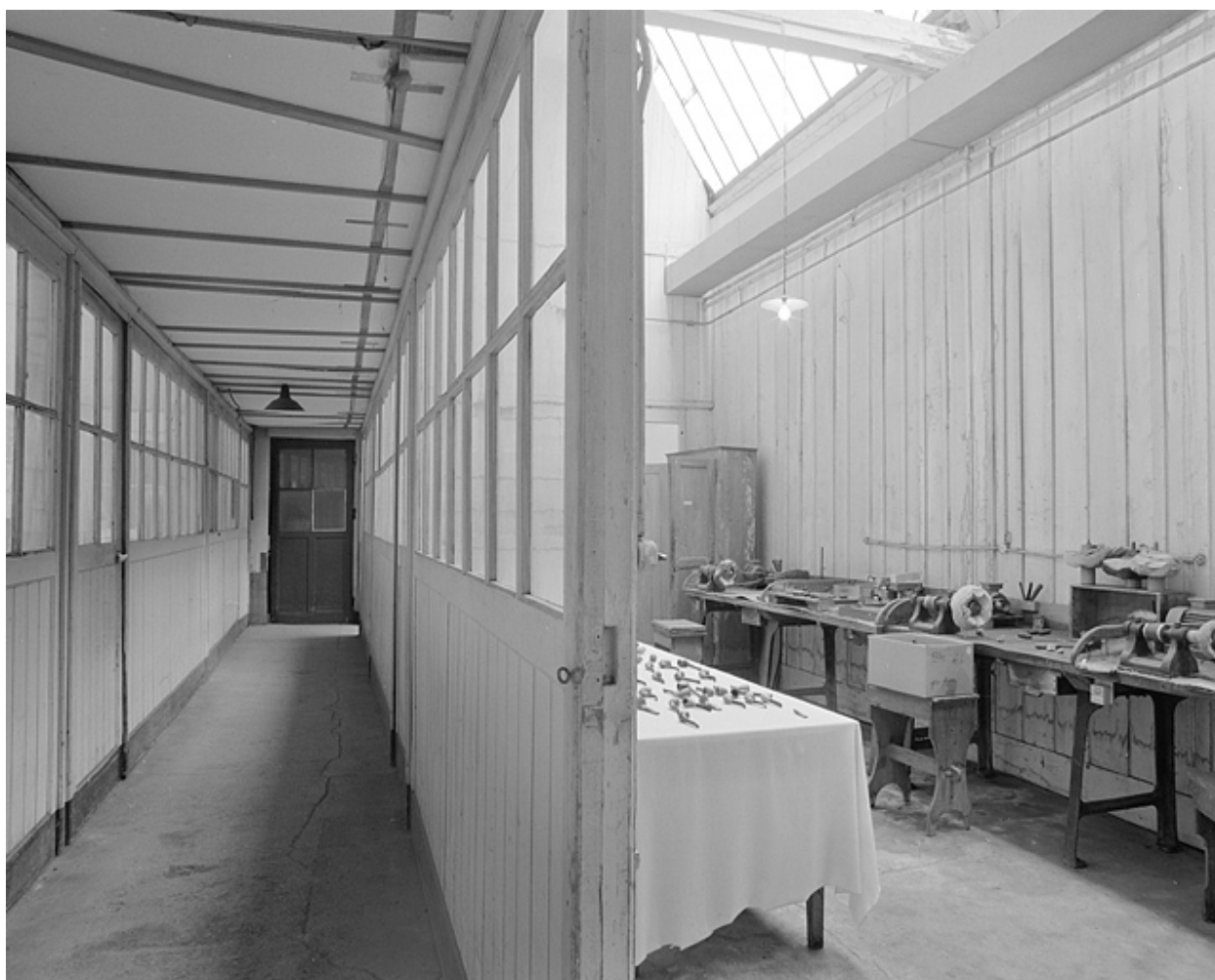
Atelier de vérification ouest.
