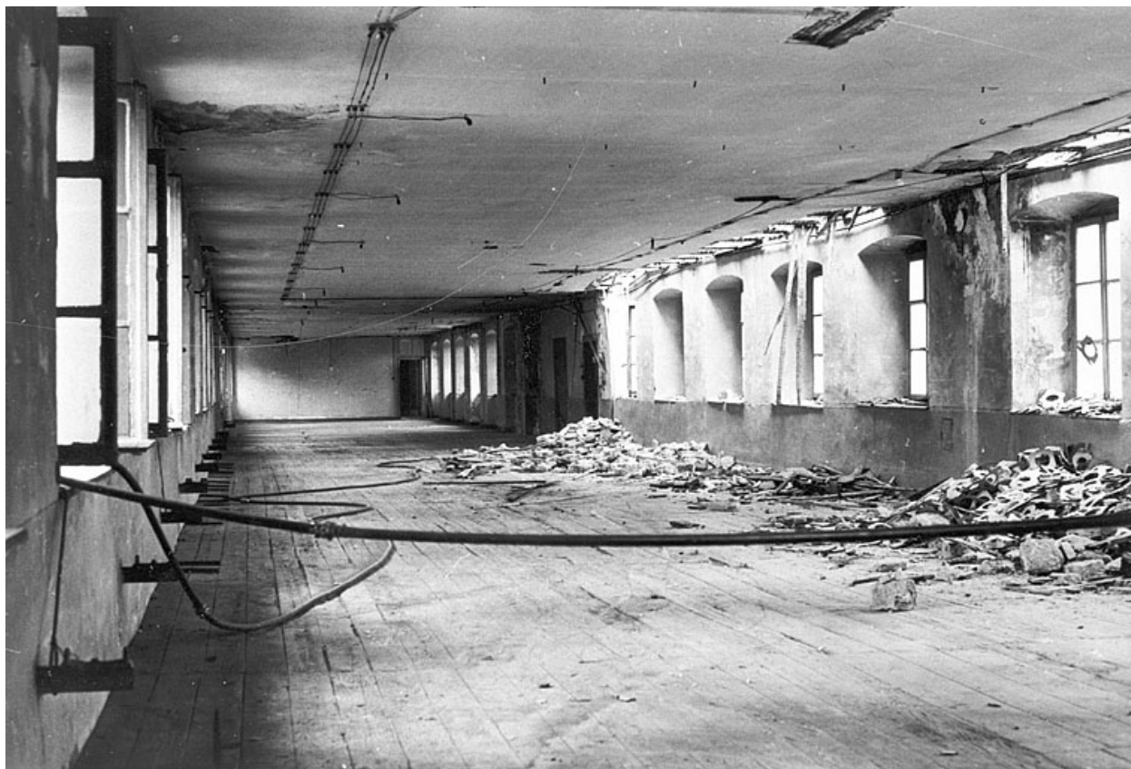
Atelier au second étage (état en 1978).
