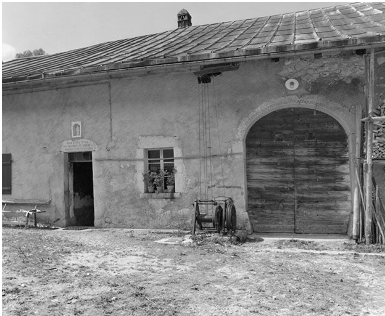
Les baies de la façade antérieure.
