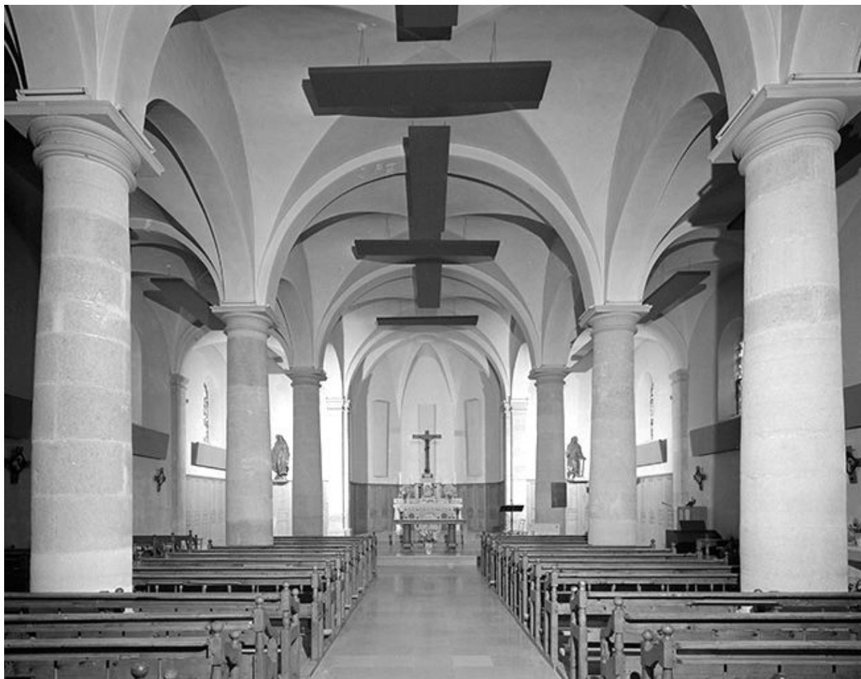
Le choeur vu depuis la nef.
