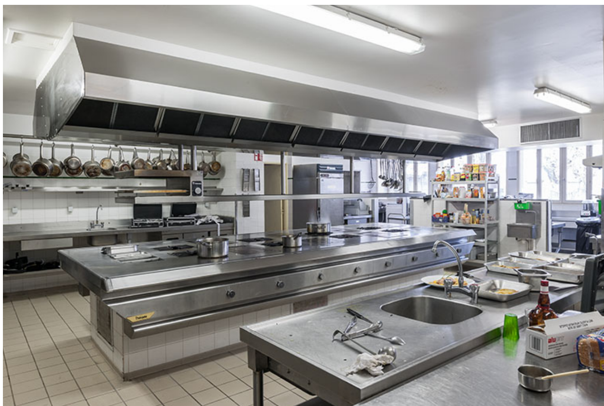
Restaurant d'application : les cuisines.
