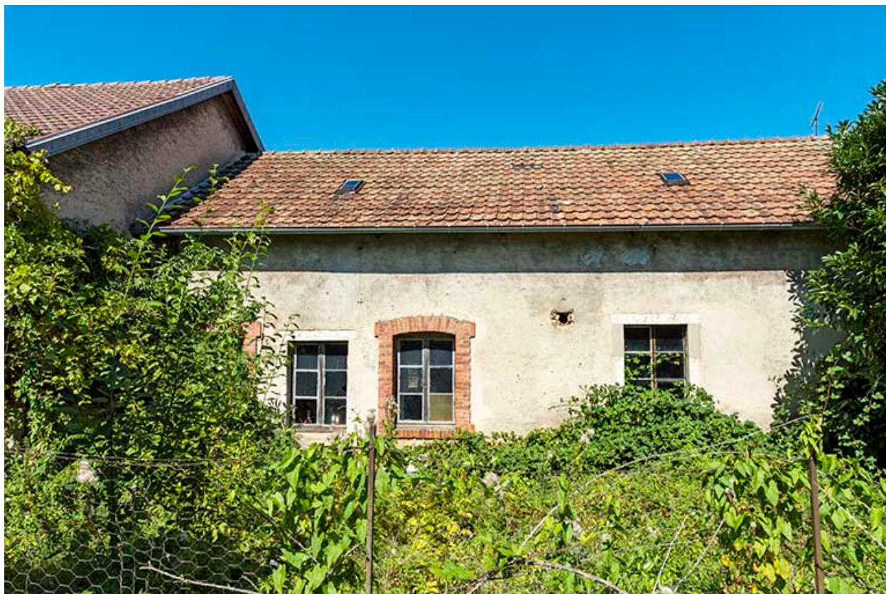
Anciennes grange et écurie : façade postérieure.
