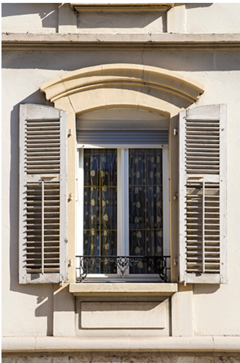
Façade antérieure : fenêtre du rez-de-chaussée.
