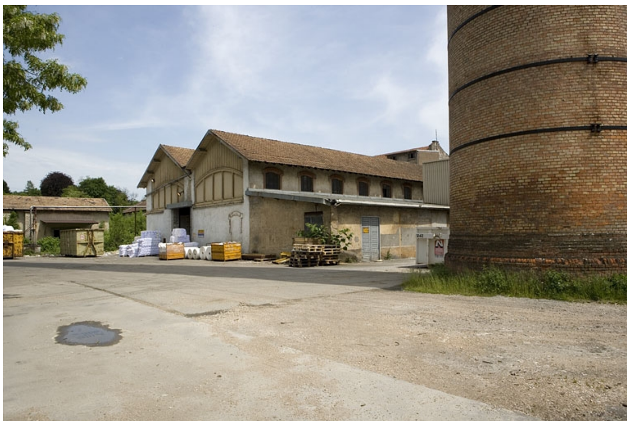
Entrepôt industriel. Pignon ouest.
