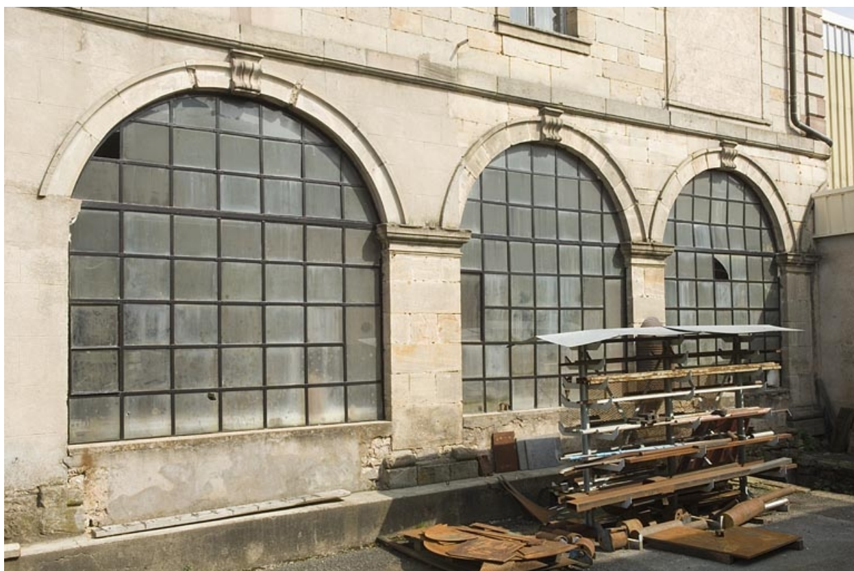
Bâtiment prieural. Baies de la façade ouest.
