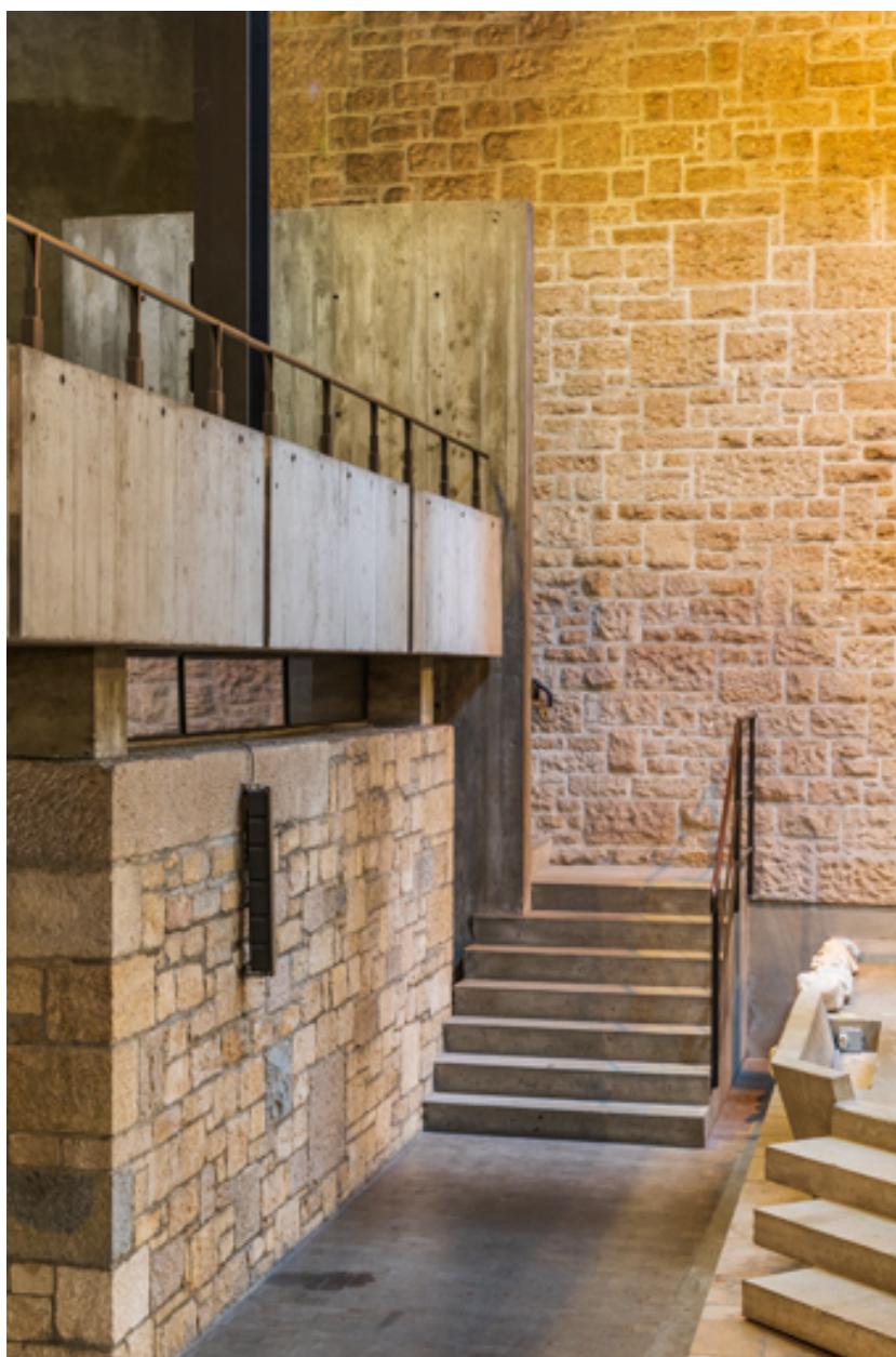
Escalier d'accès à la tribune ouest.
