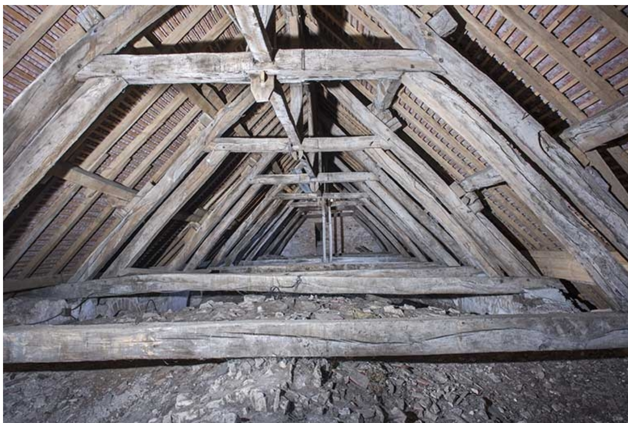
Vue d'ensemble de la charpente.
