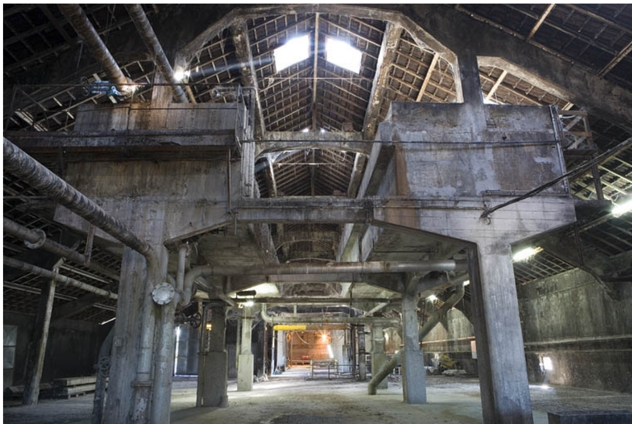
Atelier de trituration. Cuves de stockage d'eau.
