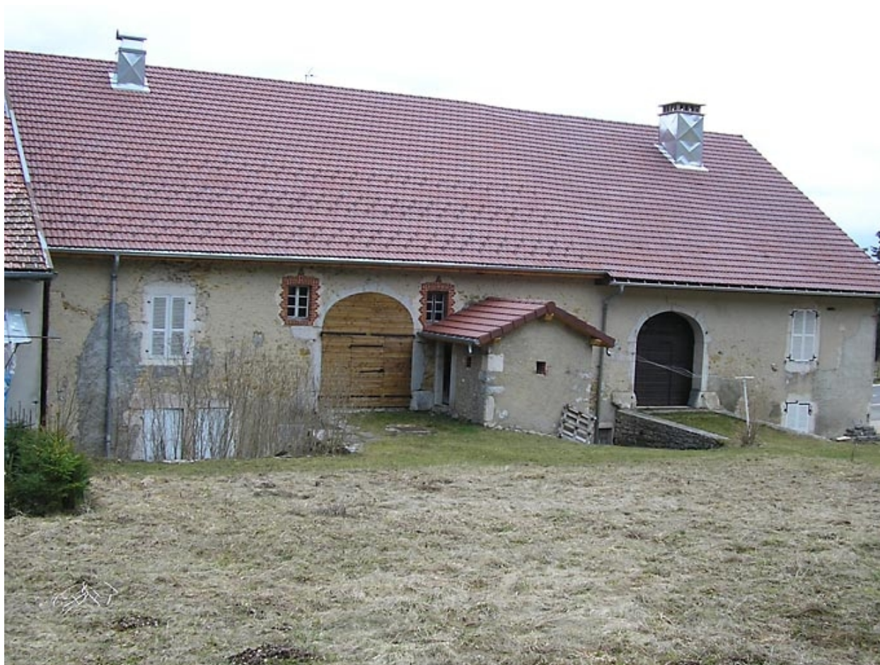
Façade postérieure et ponts de grange.
