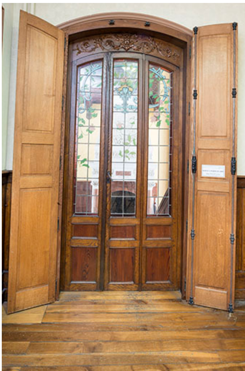
Porte d'accès vers la salle de bal.
