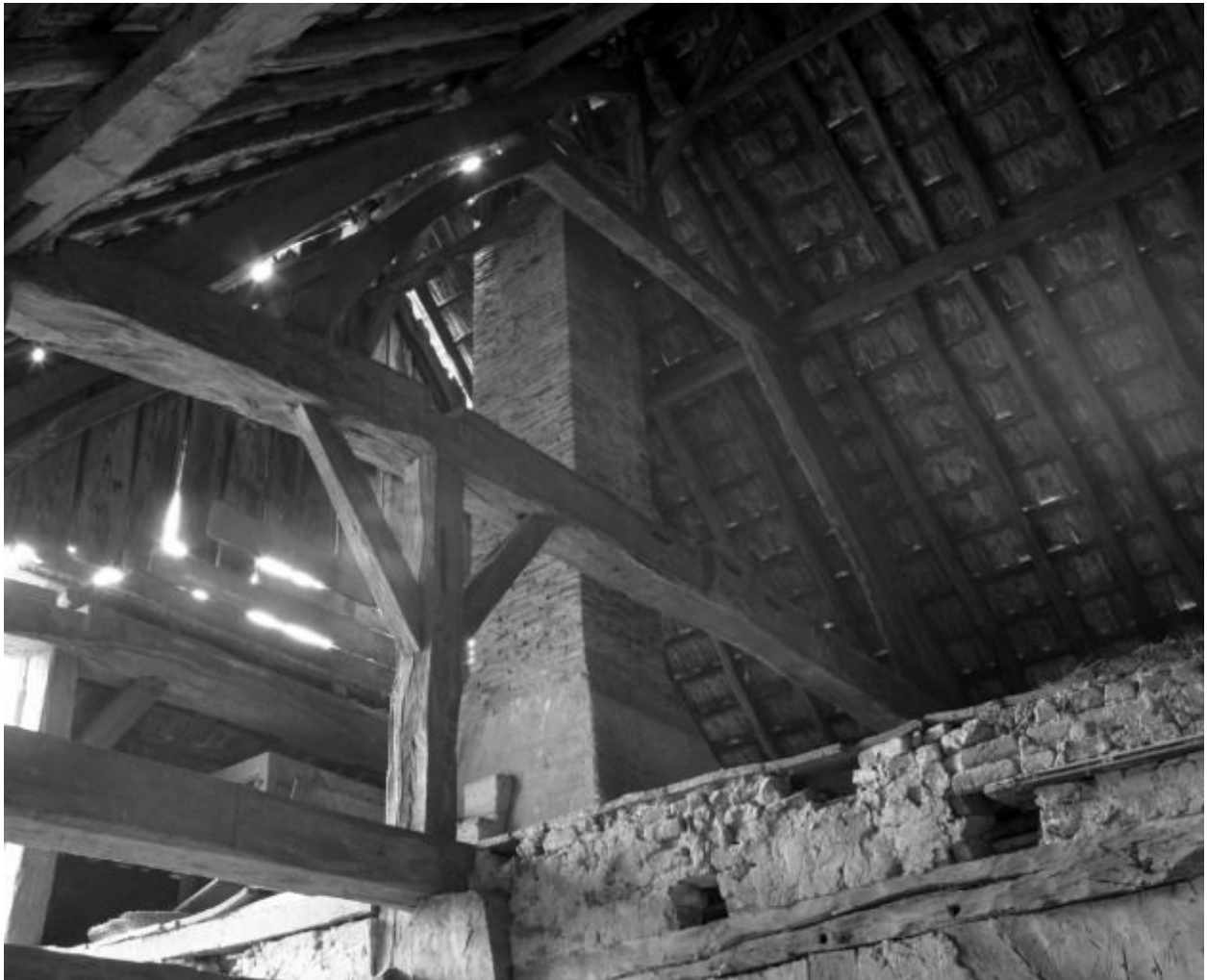
Conduit de cheminée et charpente.
