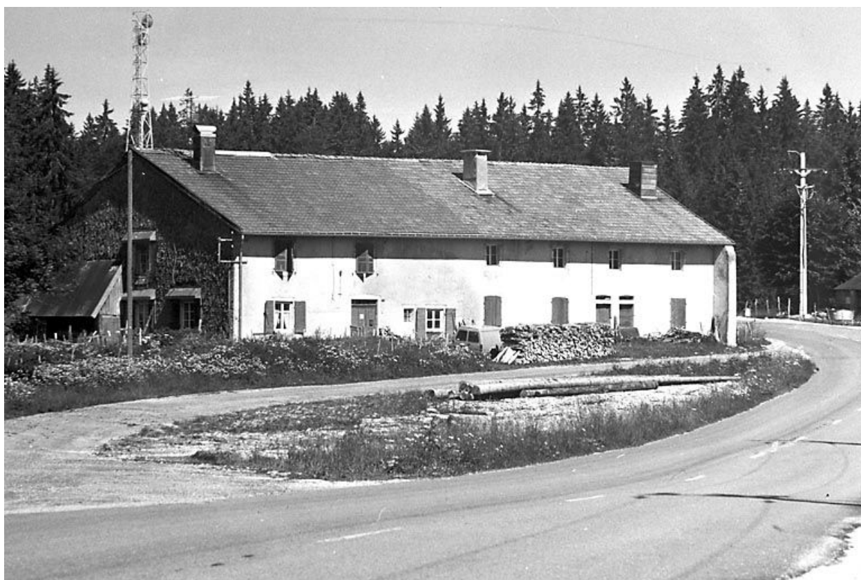
Vue éloignée de la façade antérieure.
