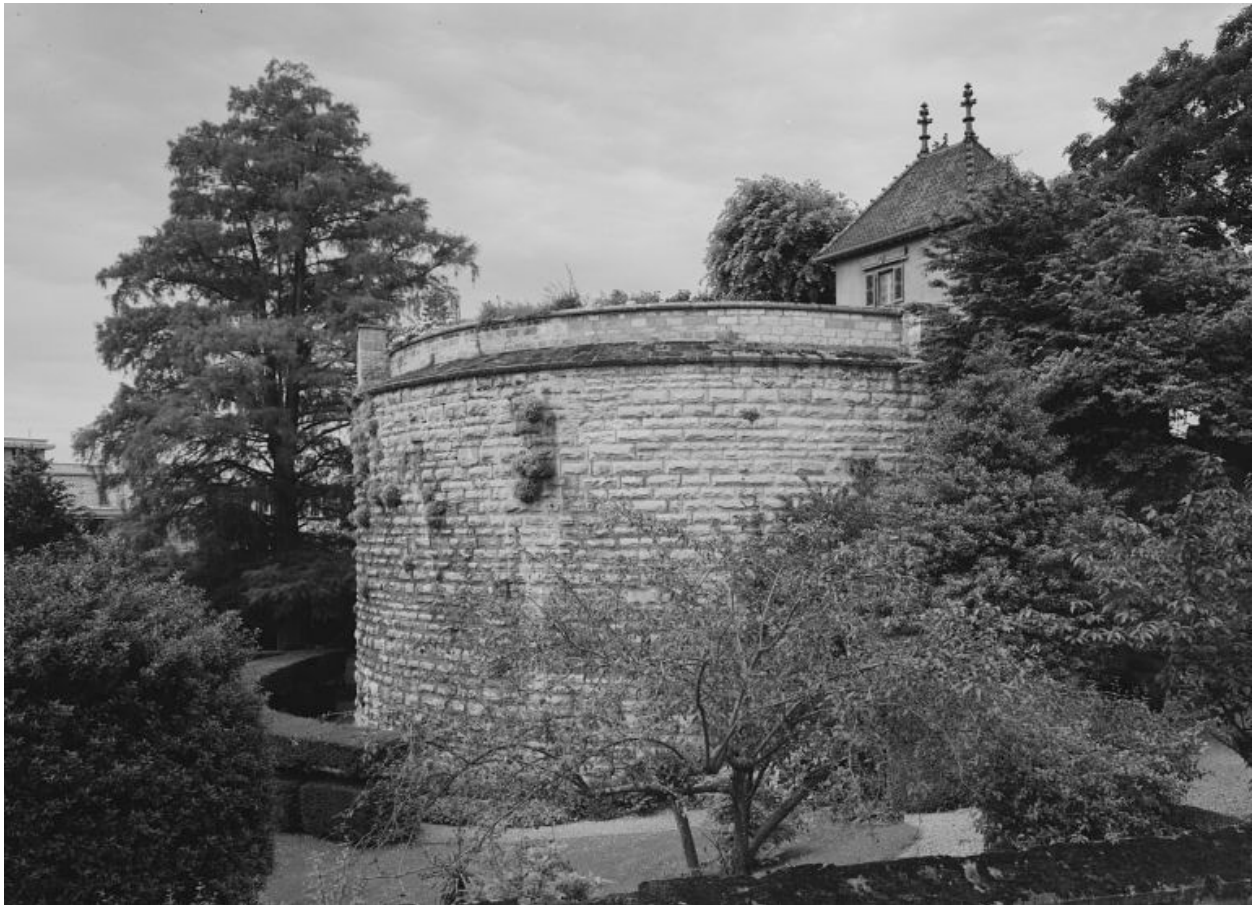
Tour sud-est depuis la rue du Château (1988).
