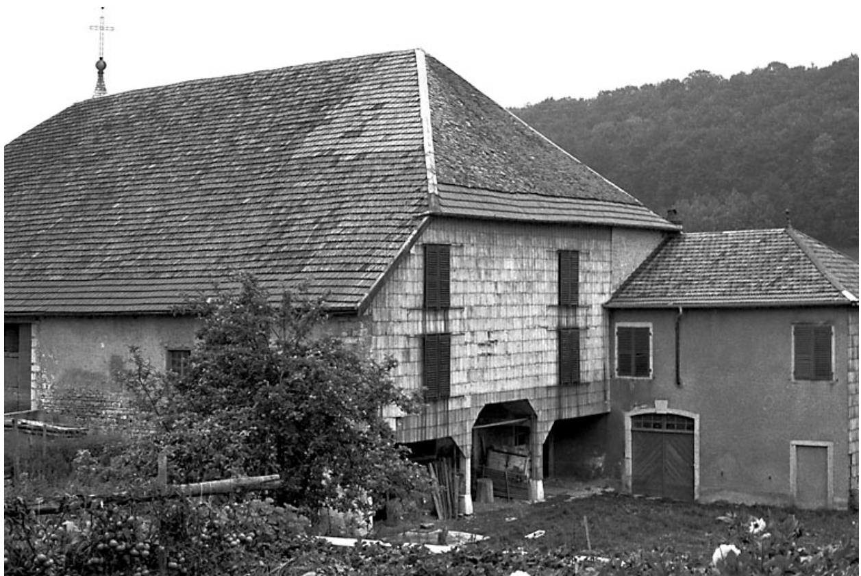
Ferme située rue de la Mairie : Vue du long pan sur rue et du pignon postérieur.
