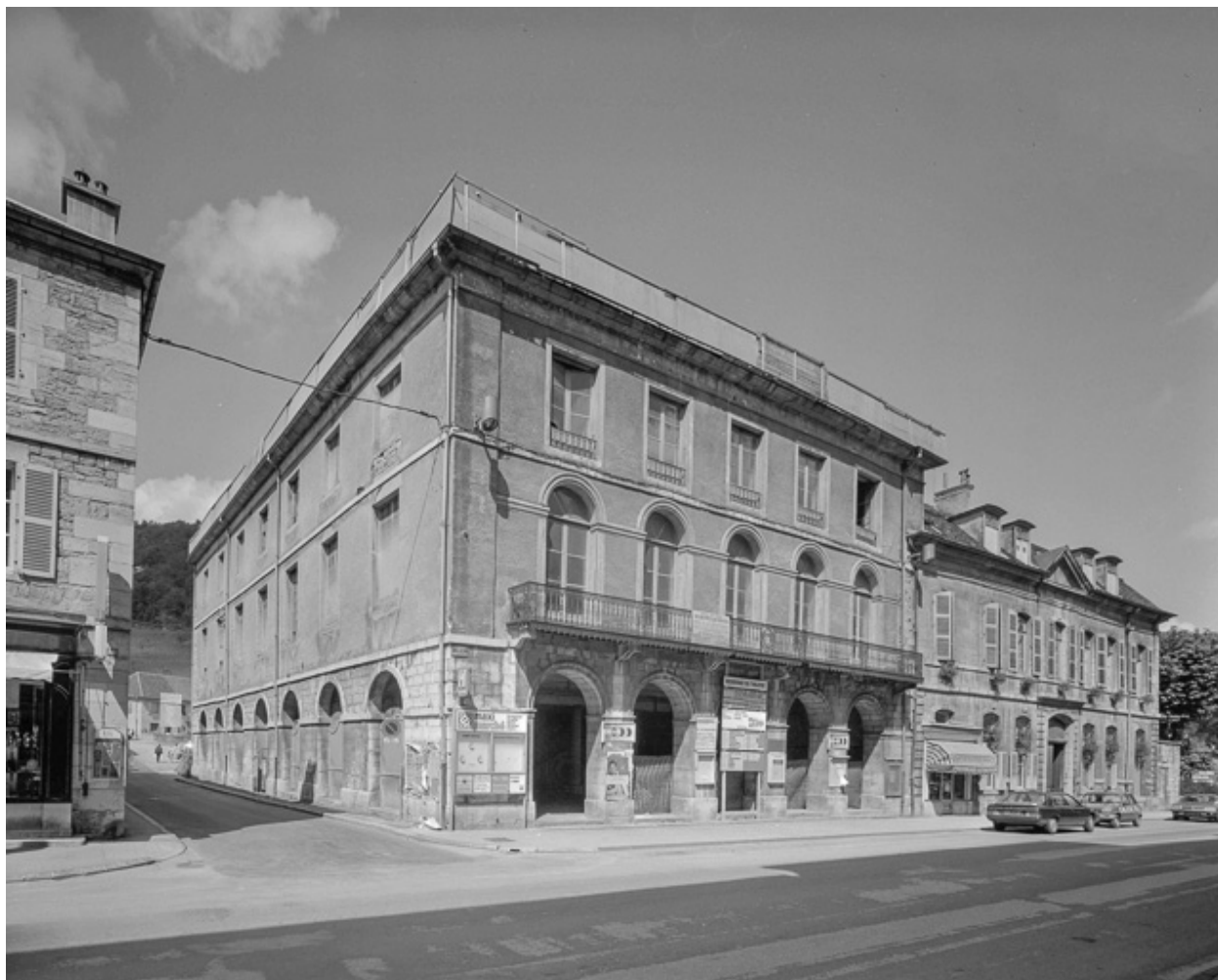
Vue avant déconstruction (1987).
